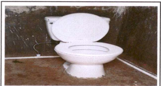
Foto 3: Sustitución de inodoro (modulo 2)
